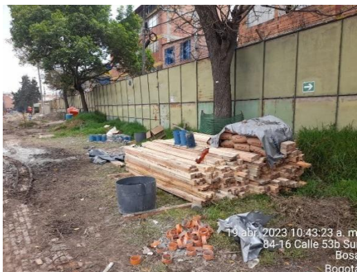
Falta de señalización y delimitación de áreas de acopio de material. Fecha: 19-04-2023.
